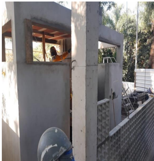
Figura 21: Novo banheiro para os usuários
