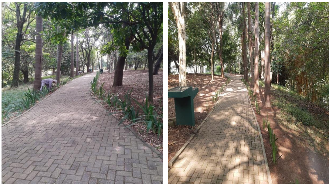
Figura 6: Despraguejamento canteiro (antes e depois)
