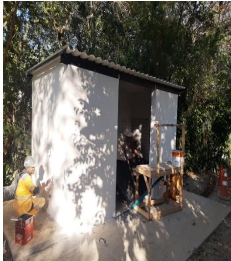
Figura 20: Abrigo de resíduos
